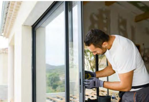
Der Einbau neuer Fenster und Türen verbessert die Energiebilanz eines Hauses. Entscheidend dafür ist ein niedriger U-Wert
